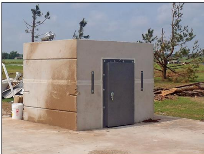
تصویر ۹- اتاق امن مسکونی تک‌منظوره پس از وقوع گردباد؛ منبع: (REMA, 2015)
